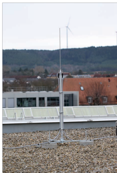
Rys. 5. Przykład montażu przewodu HVI light plus na dachu płaskim
